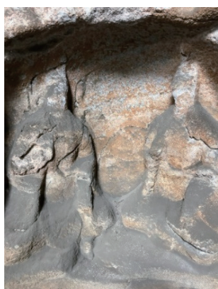
图 1 云冈石窟窟内佛像风化破坏现象
