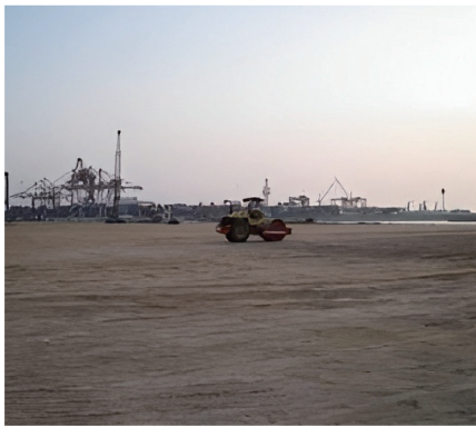
图 3 振动碾压施工 Fig. 3 Vibration rolling construction
